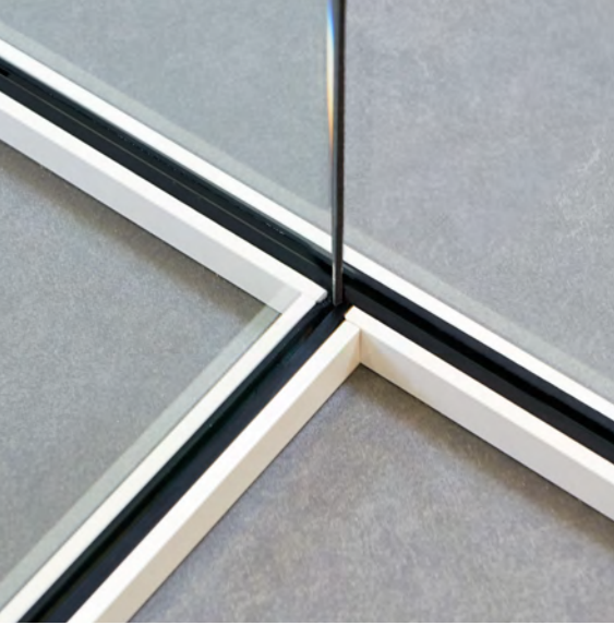
T-Anschlüsse vollständig aus Glas
