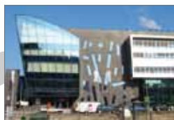
GROENINGE KRANKENHAUS BELGIEN
